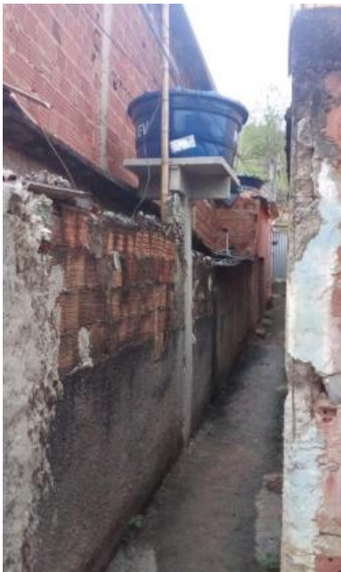
a) Instalação de caixa d'água
