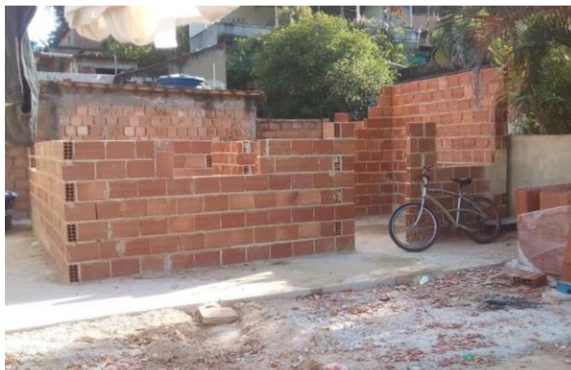
c) Construção de casa
